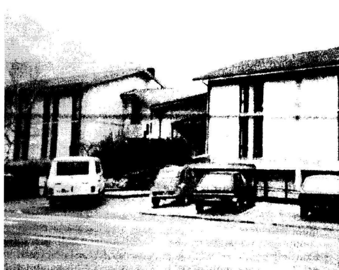
La sede amministrativa dell'Ussl della val Pellice
